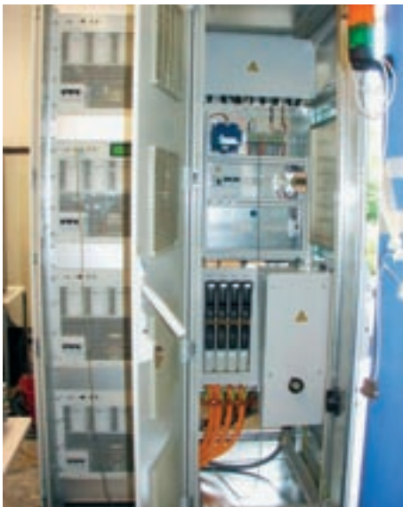
32 kW TopCon Netzgeräte in Parallelbetrieb, flüssiggekühlt Strombereich 0...2000 A
