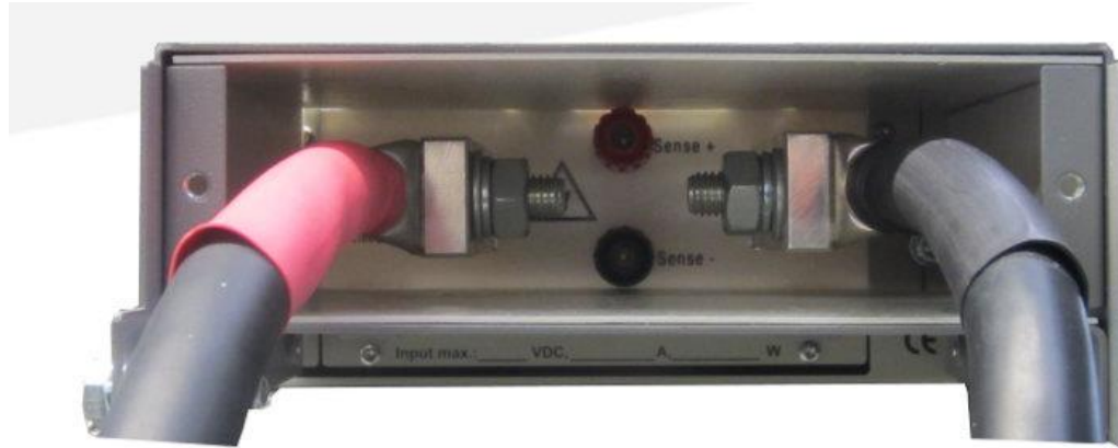
Abbildung 2.21: Sicherheitsabdeckung für Geräte ab 5 HE mit angeschlossenen Last-Kabeln
